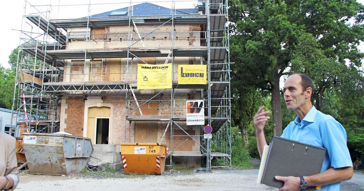
Hochbauamtsleiter Ullrich Pfuhlmann erläutert, welche Kosten die Fassadensanierung an der Schrickervilla verursacht.
